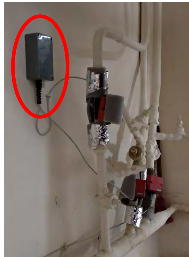
Беспроводной преобразователь с 2 каналами термометров сопротивления
