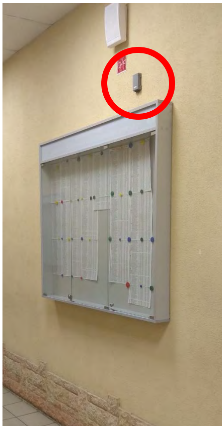
Датчики температуры и влажности в различных помещениях
