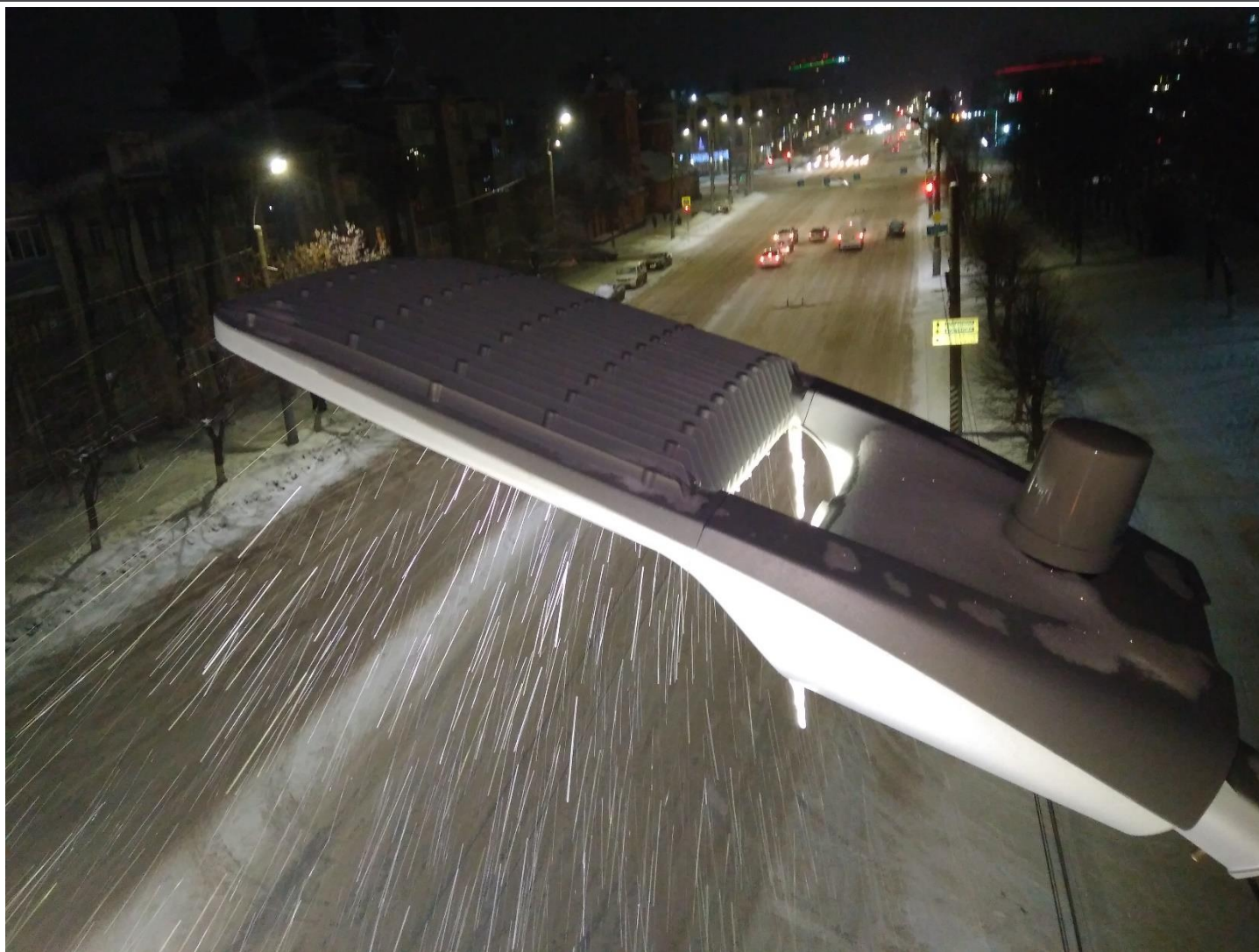
На фото – система освещения с модулем LoRa
