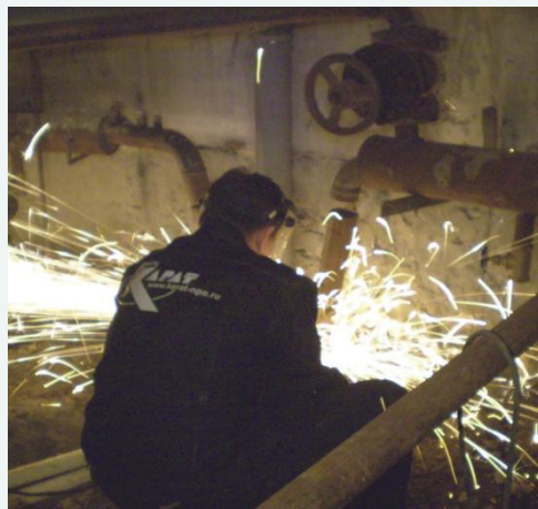
Монтаж и наладка
