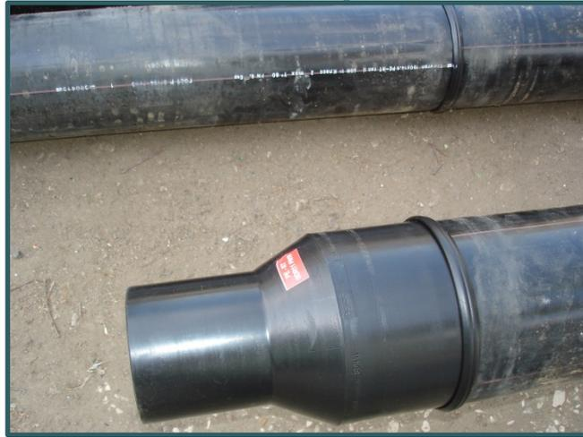
Сборка трубопровода с фасонными частями
