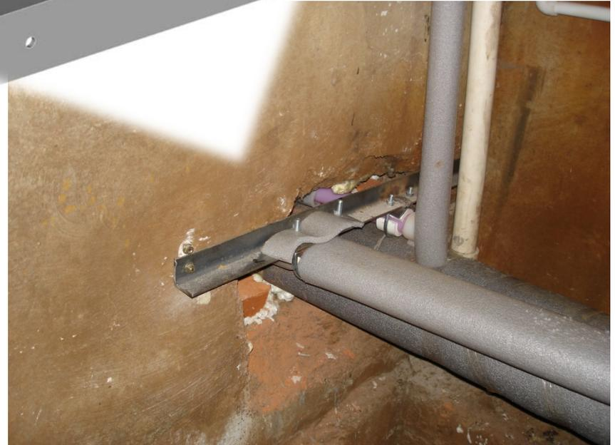
Ремонт сети отопления, 85 0С. Прокладка в ППС коробах над каналами. РТ, Мамадышский район, 2015 г. Трубы PERT тип2 SDR11 ф90\*8,2. Раструбная сварка.
