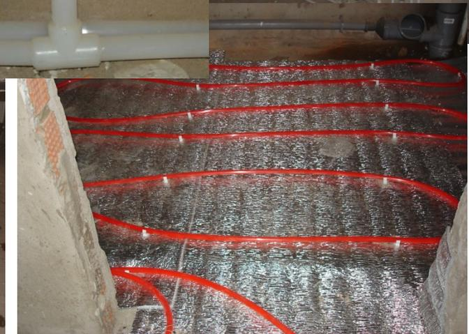
Поквартирное отопление. г. Ижевск, 9-ти этажный, 240-квартирный жилой дом. Май-июнь 2016 г. Трубопроводы высокотемпературного радиаторного отопления (5-й класс эксплуатации, 80 0С) . Трубы RUS-PERT SDR8 диаметр 16x2,0 мм. Цвет труб и фитингов - натуральный, ненасыщенный белый. Общая длина 16000 м. Трубы в бухтах по 200 м. Компрессионный фитинг (евроконус) LUXOR.
