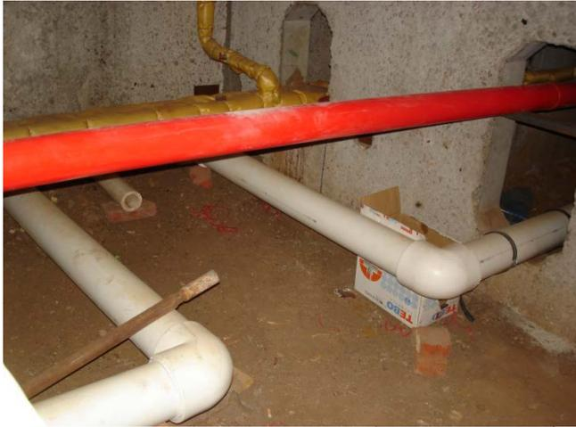
PPR трубопровод подающий, с компенсаторами, скользящими и жесткими опорами, сварка муфтовая. Длина – 120 м., срок производства работ 20 дней
