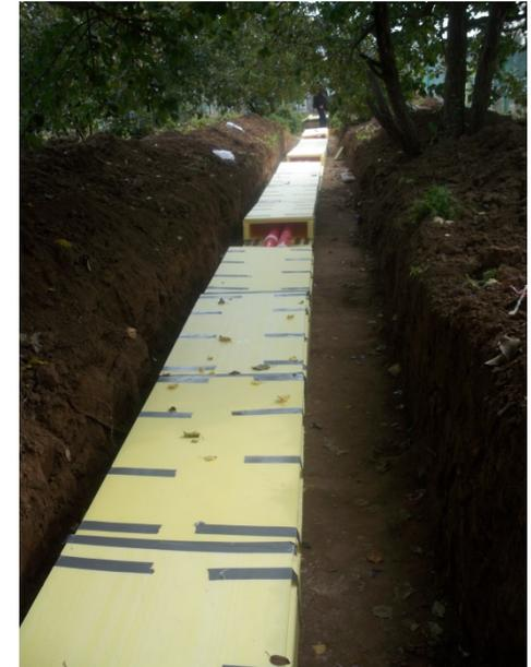
**Поквартирное отопление.** Г. Можга, 6-ти этажный, 90-квартирный жилой дом. Ноябрь 2014 г. Трубопроводы высокотемпературного радиаторного отопления (5-й класс эксплуатации, 80 °С) . Трубы RUS-PERT SDR7,4 диаметр 20x2,8 мм. Цвет труб и фитингов - натуральный, ненасыщенный белый. Общая длина 2500 м. Трубы в бухтах по 200 м. Раструбная ручная сварка.
