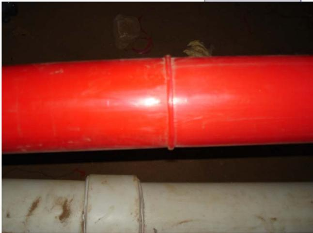
PERT трубопровод – циркуляция, без компенсаторов, со свободной укладкой, сварка встык. Длина -120 м., срок производства работ 5 дней.
