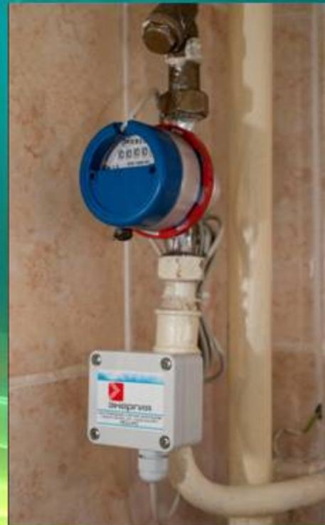
Беспроводной мониторинг потребления горячей воды в квартире.
