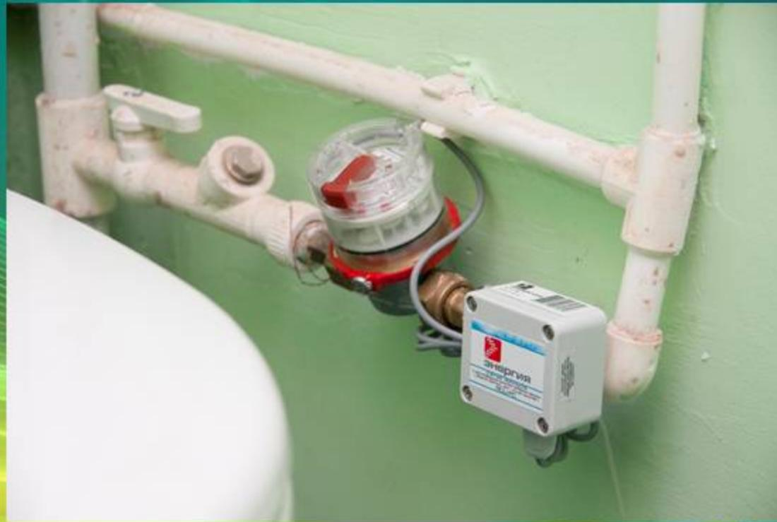
Беспроводной мониторинг потребления холодной воды в квартире.
