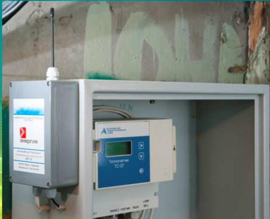
Беспроводной мониторинг параметров теплоснабжения жилого дома.
