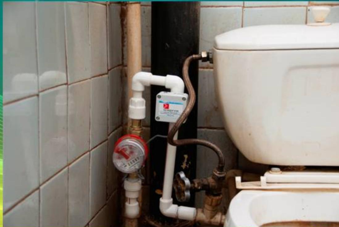
Беспроводной мониторинг потребления холодной воды в квартире.
