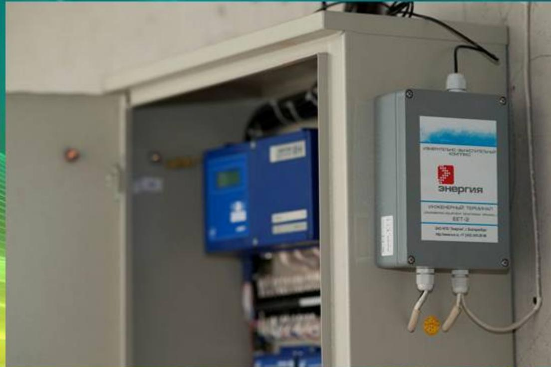
Беспроводной мониторинг параметров теплоснабжения жилого дома.
