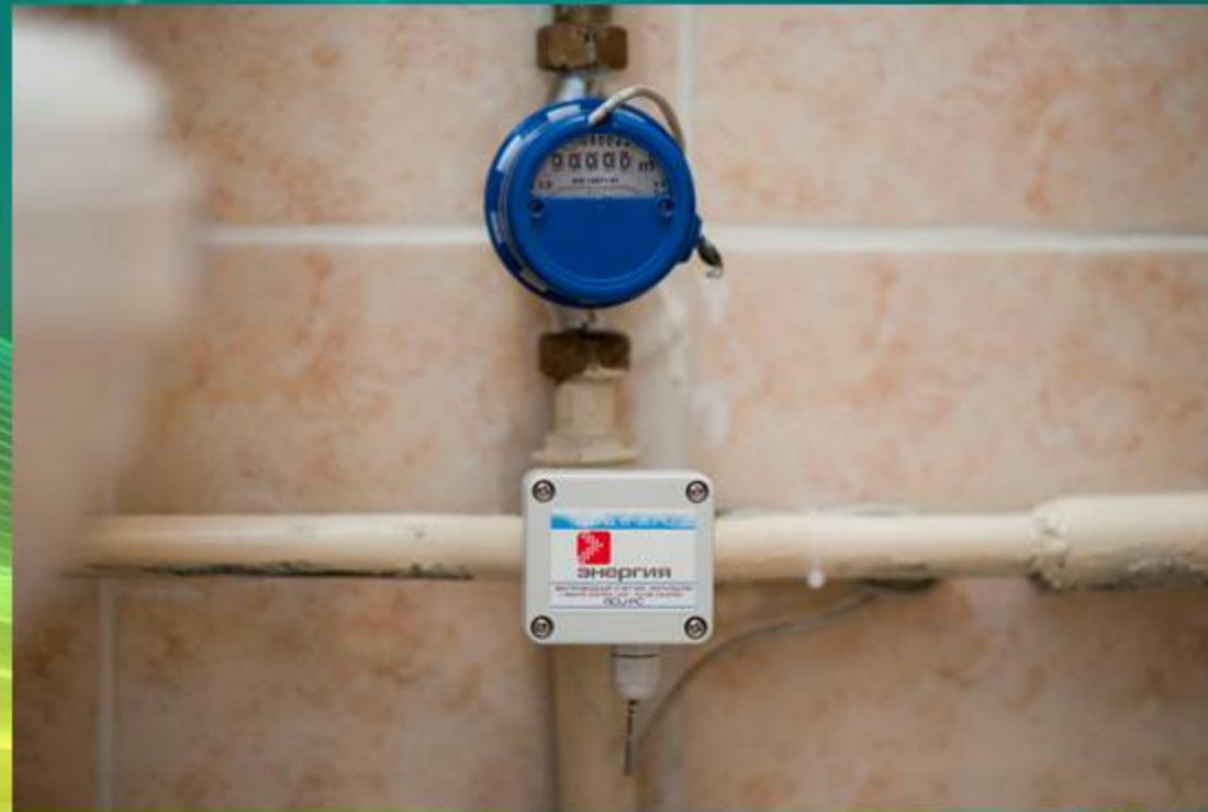
Беспроводной мониторинг потребления холодной воды в квартире.
