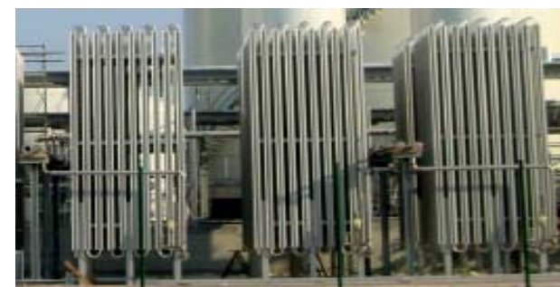
Комплекс регазификации СПГ 10 тыс. стм 3 /час
