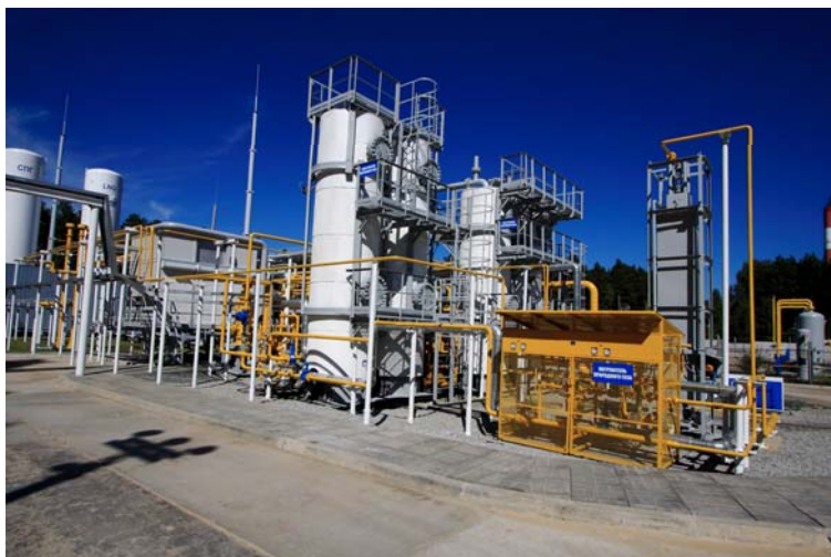
Блок очистки и осушки
