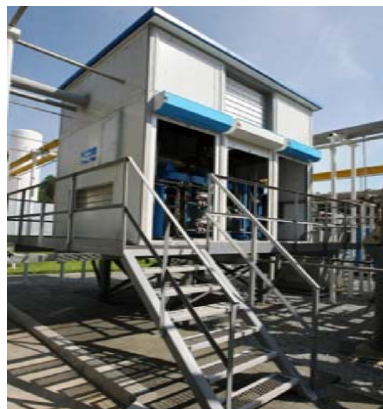
Блок турбодетандера
