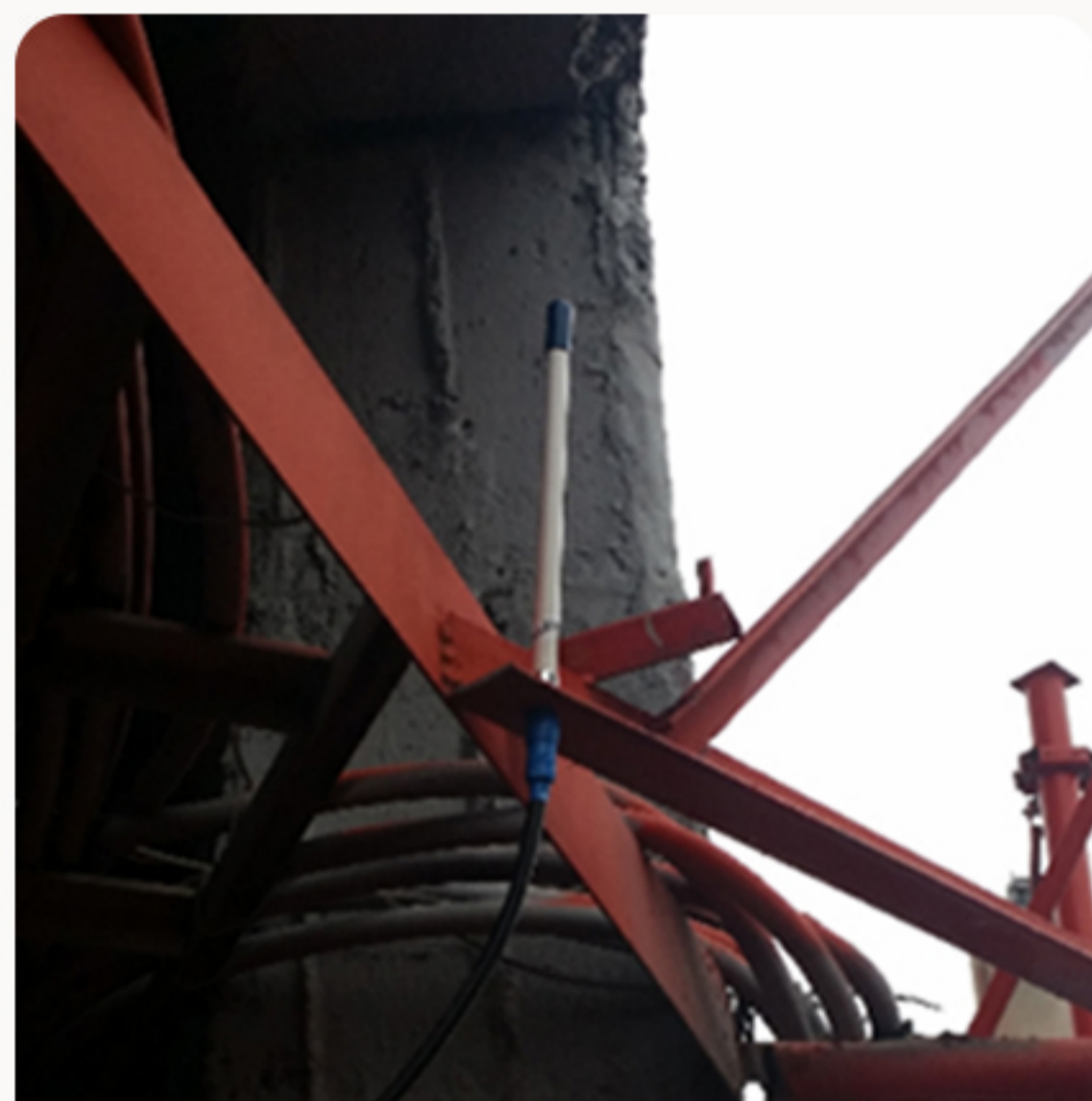
Базовая станция Kerlink на ТЦМС14 (Асбестовский 4а) (высота размещения 65 м)
