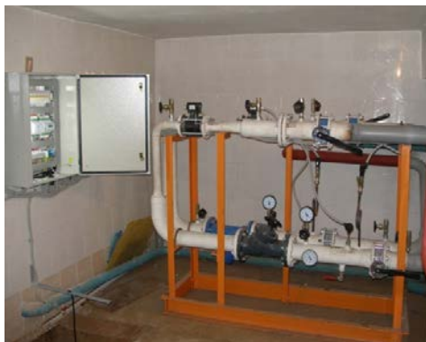
Автоматизированные тепловые пункты зданий ЮУрГУ
